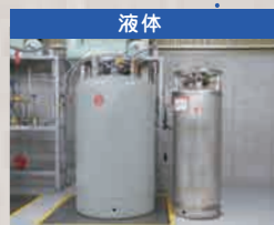
超低温液化ガス容器 495ℓ型容器 (左) と 175ℓ型容器 (右) があります。
